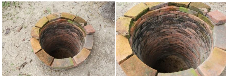
ภาพที่ 6 บ่อน้ำก่ออิฐ ณ เขานางทอง
