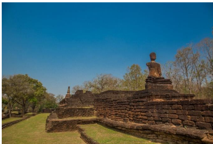
ภาพที่ 9 ภาพโครงสร้างส่วนฐานของสิ่งก่อสร้างบริเวณวัดพระธาตุ
